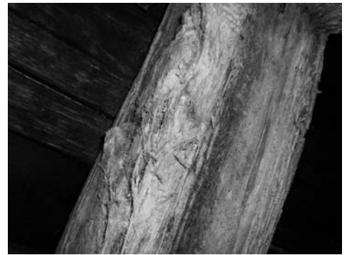
7. ábra (p2100206) kémiai korrózió szarufán
