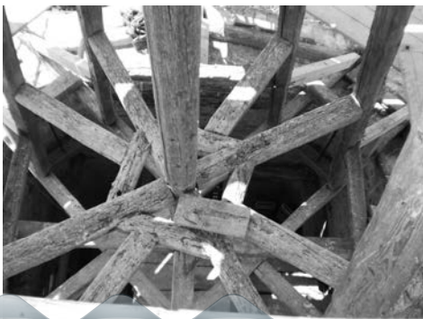
4. ábra (p7150114) a toronysisak eredeti tarósszerkezete
